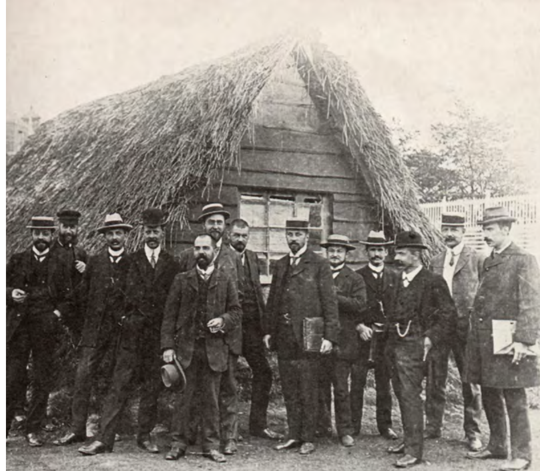
De Woningwet gaf gemeenten extra bevoegdheden om op te treden tegen slechte of onbewoonbare woningen. Op de foto de Amsterdamse gezondheidscommissie op inspectie in Amsterdam-Oost. Helemaal rechts Arie Keppler, vanaf 1915 directeur van de Woningdienst en namens de gemeente Amsterdam toezien commissaris van de Bouwmaatschappij.
