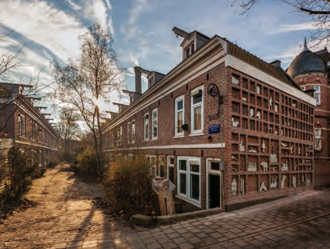
◀ Woonblok in de Hugo de Grootbuurt (Frederik Hendrikstraat, Derde Hugo de Grootstraat, de Van Houweningenstraat en op het Hugo de Grootplein) in aanbouw. Foto Albert Greiner, 13 oktober 1886. Architect Jan Willem Zoutseling.
